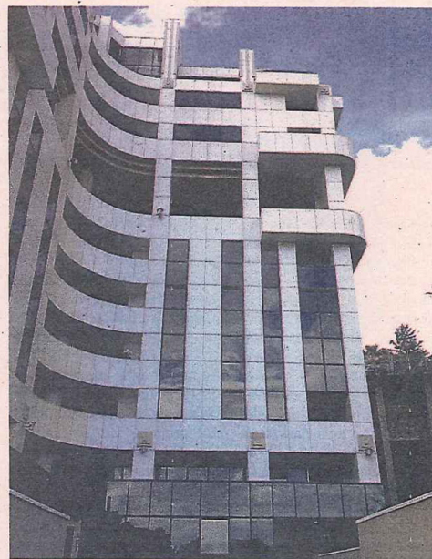
La sede con gli uffici centrali in Catanzaro
